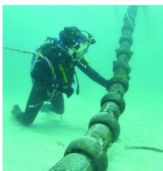
Coquilles articulées (source : windsystemsmag.com )
